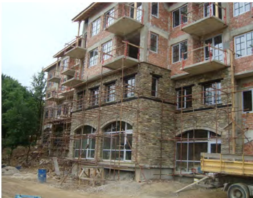
Комплексна сграда "Courtyard" в процес на изграждане.
